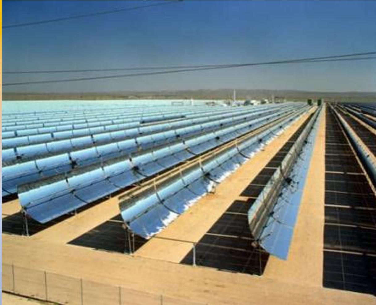
**Солнечная теплоэлектростанция с парабоцилиндрическим концентратором**
