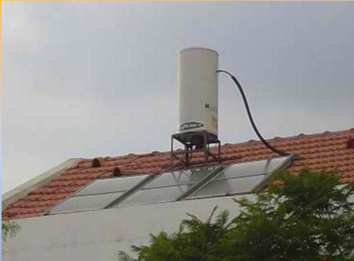
Плоский солнечный коллектор для горячего водоснабжения
