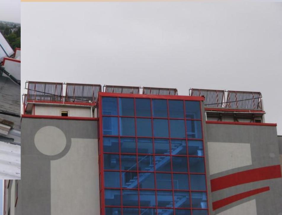
**Система вакуумных коллекторов** площадью 16 м<sup>2</sup> (8 коллекторов) с общей емкостью баков-накопителей 1200 л (4 бака) для ГВС.
