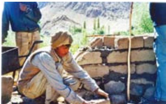
опытным каменщикам удастся строить двойные стены используя один каркас, имеющими два слоя спрессованной земли (2 x 20см) с промежуточным слоем из соломы толщиной в 10см!!!
