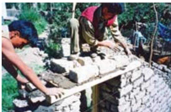
Фото 24 - Кладка вокруг дверного проема в несущей стене.
