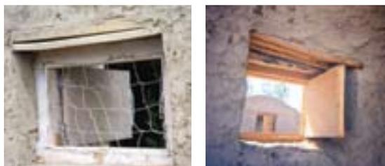
Фото 28 и 29 - Установленное боковое вентиляционное отверстие, затянутое проволочной сеткой
