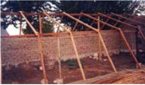
Схема 25 - Строительство стен, установка балок
