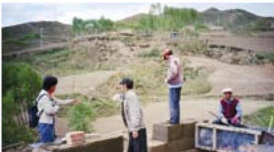
Фото 15 и 16 - Определение формы будущей стены при помощи веревки (в Кингае и Ладахе)
