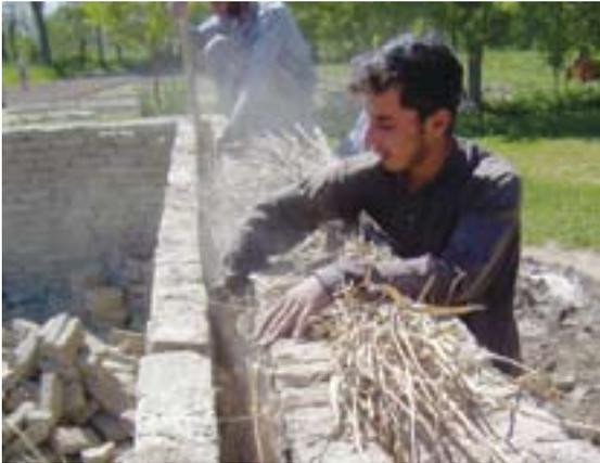
Фото 19 - Двойная стена и теплоизоляционный наполнитель.
