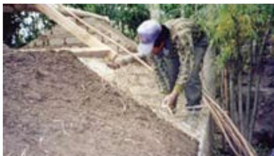
Фото 36 - Покрывание крыши картоном, соломой и глиной
