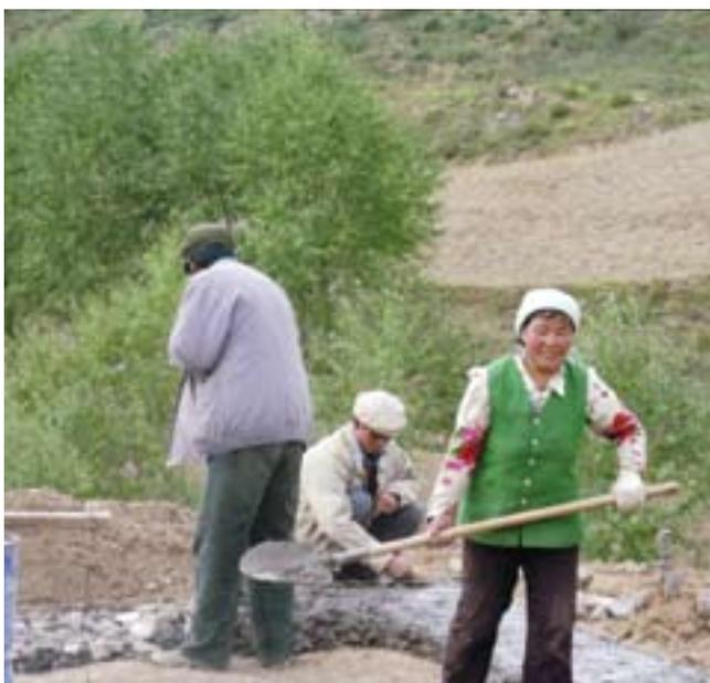
Фото 14. - Пятисантиметровый слой бетона поверх фундамента
