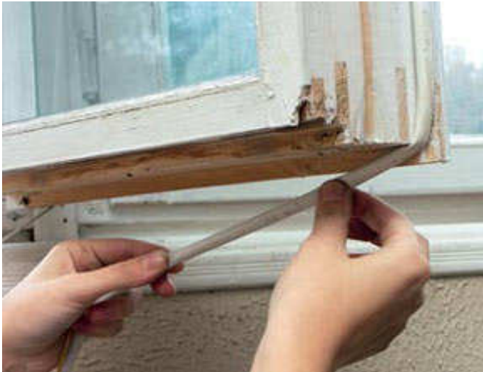
Установка уплотняющей ленты
