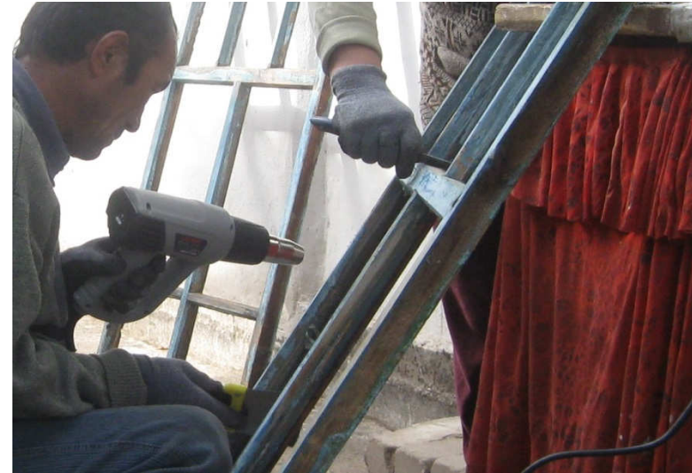
Снятие старого слоя краски
