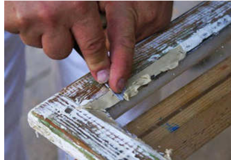
Нанесение оконной замазки
