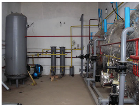
Рис. 16. Биогазовая установка КФХ «Ак-Сарай», 200 м 3 Объем реакторов, м 3 – 200, пропускная способность по навозу, – 12 т/сутки, – 4000 т/год, производительность по биогазу, – 360 м 3 /сутки, – 120000 м 3 /год, газгольдер, м 3 – 20
