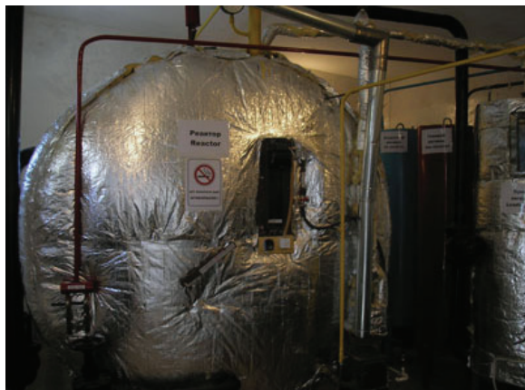
Рис. 13. Биогазовая установка Профессиональный лицей №43, 10 м 3 Объем реакторов, м 3 – 10, пропускная способность по навозу, – 0,6 т/сутки, т/год 200 т/год, производительность по биогазу – 18 м 3 /сутки, – 6000 м 3 /год, газгольдер, м 3 – 10
