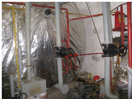
Рис. 15. Биогазовая установка Жамаат «Заря», 50 м 3 Объем реакторов, м 3 – 50, пропускная способность по навозу – 3 т/сутки, – 1000 т/год, производительность по биогазу – 90 м 3 /сутки, – 30000 м 3 /год, газгольдер, м 3 – 10
