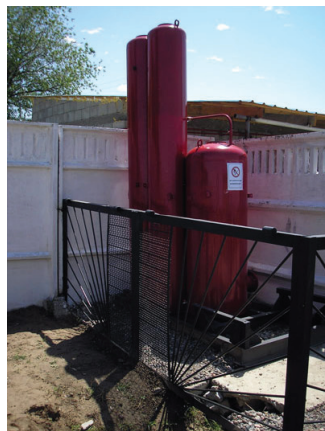
Рис. 13. Биогазовая установка Профессиональный лицей №43, 10 м 3 Объем реакторов, м 3 – 10, пропускная способность по навозу, – 0,6 т/сутки, т/год 200 т/год, производительность по биогазу – 18 м 3 /сутки, – 6000 м 3 /год, газгольдер, м 3 – 10
