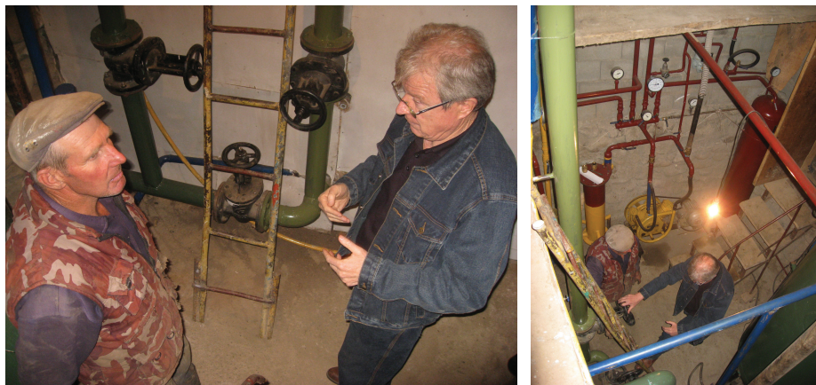
Рис. 14. Биогазовая установка КХ «Фаворит», 25 м 3 Объем реакторов, м 3 – 25, пропускная способность по навозу, т/сутки – 1,5, пропускная способность по навозу, т/год – 500, производительность по биогазу, м 3 /сутки – 45, производительность по биогазу, м 3 /год – 15000, газгольдер, м 3 – 5
