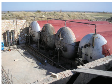
Рис. 16. Биогазовая установка КФХ «Ак-Сарай», 200 м 3 Объем реакторов, м 3 – 200, пропускная способность по навозу, – 12 т/сутки, – 4000 т/год, производительность по биогазу, – 360 м 3 /сутки, – 120000 м 3 /год, газгольдер, м 3 – 20
