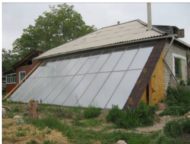
30-сүрөт. Үйдү жылытуучу система катарында иштөөчү, үйдүн түштүк тарабына орноштурулган теплицасы бар үй.
