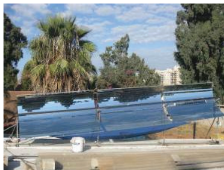
16-сүрөт. Параболикалык топтогучтуу күн топтогучу
