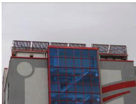
**Рис. 27.** Вакуумный солнечный водонагревательный коллектор площадью 16 м<sup>2</sup> (8 коллекторов) с общей емкостью баков-накопителей 1200 л (4 бака) для ГВС гостиницы.
