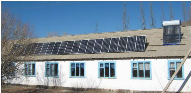
**Рис. 26.** Вакуумная солнечная водонагревательная установка на 100 л. (справа) для ГВС столовой. Фотоэлектрическая станция мощностью 2 кВт (слева) для электроснабжения здания школы; площадь фотомодулей 12 м<sup>2</sup>.
