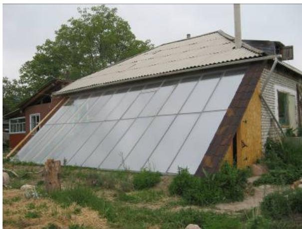
**Рис. 30.** Дом с теплицей, пристроенной к южной стороне дома, которая действует в качестве системы отопления дома.
