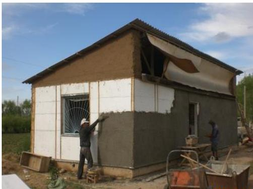
**Наружные стены.** Существующие глинобитные стены были обладали недостаточной толщиной и соответственно через них были большие теплотери. Поверх глинобитных стен была нанесена цементно-песчаная штукатурка. Во многих местах штукатурка отошла от стен.
