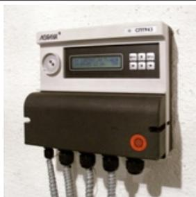
Теплосчетчик Sonometer 2000 - общедомовой, предназначен для измерения и учета тепловой энергии и количества теплоносителя в закрытых и открытых водяных системах теплоснабжения.
