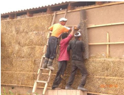
Западная стена была утеплена легкой смесью глины – соломы, толщиной 10 см, Южная и Восточная стена была утеплена пенопластом, толщиной 5 см.
